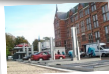
48 gerealiseerde plaatsen - parkeersystemen G63 outdoor
